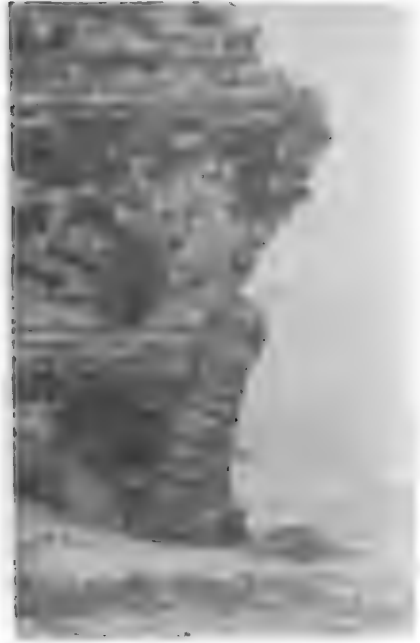
Fig. 7. — Détail de l'arc : face interne.
